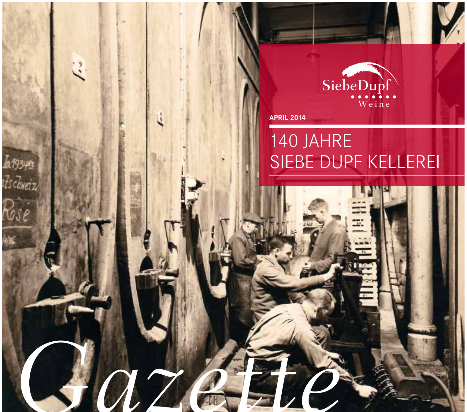
Arbeiten im alten Fasskeller
